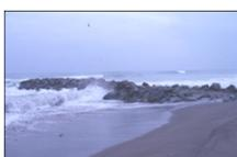
Durante el desarrollo del trabajo, se realizó una inspección ocular a la zona de estudio, donde se pudo apreciar la presencia de una estructura de característica impermeable (espigón) de aproximadamente 20 m de longitud y que se extiende de manera perpendicular desde la línea de costa hacia el mar.
